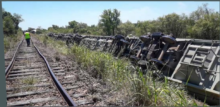
Rail buckling causing derailing in Argentina © Junta de Seguridad en el Transporte
